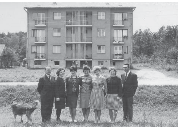
Zaposleni v šoli ob novozgrajenem bloku v 60. letih.
